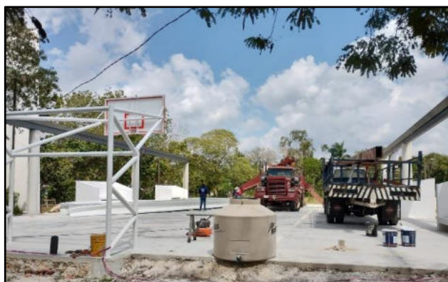
En esta foto se están colocando las estructuras de metal donde irán colocado el techado del Domo.
