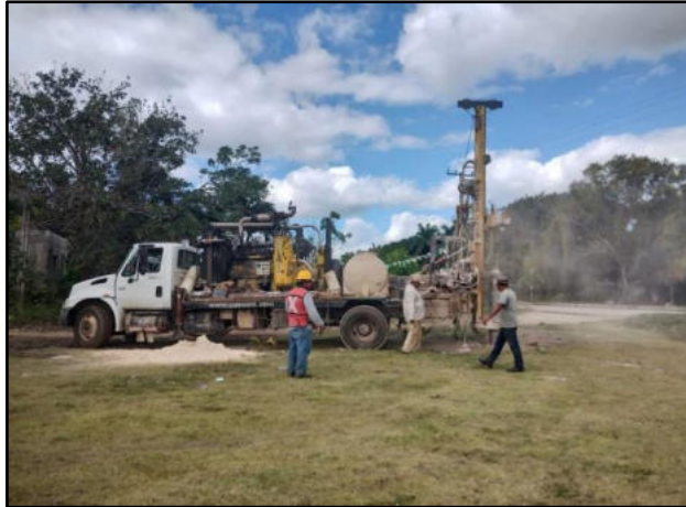
Perforación del suelo donde se instalarán las columnas para el techado del Domo.
